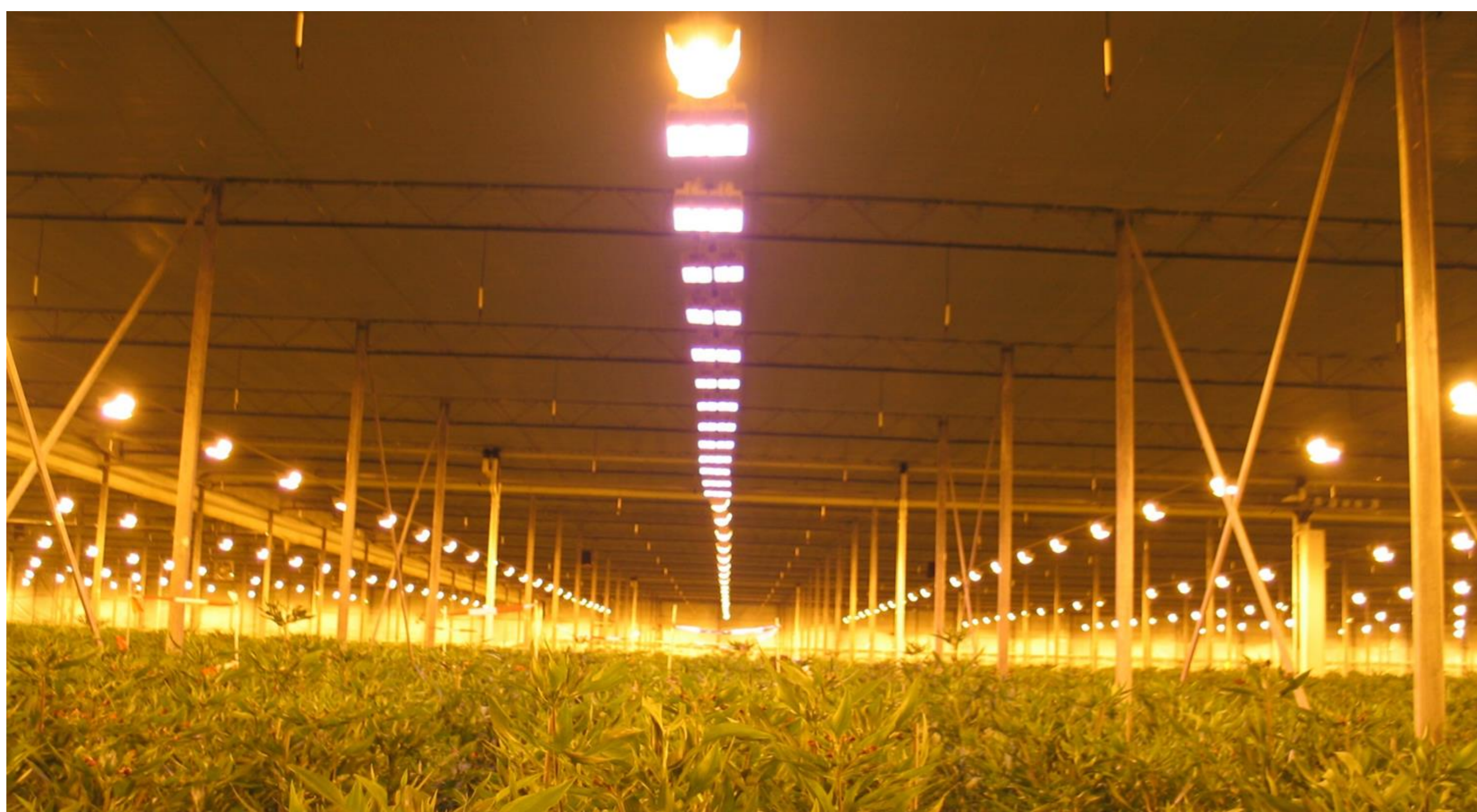
Figuur 1. Op een praktijkbedrijf zijn 2 belichtingsbehandelingen in ras Lovely aangelegd; LED (Valoya R300 AP67) en SON-T (LI papillon 1000W) lampen.
