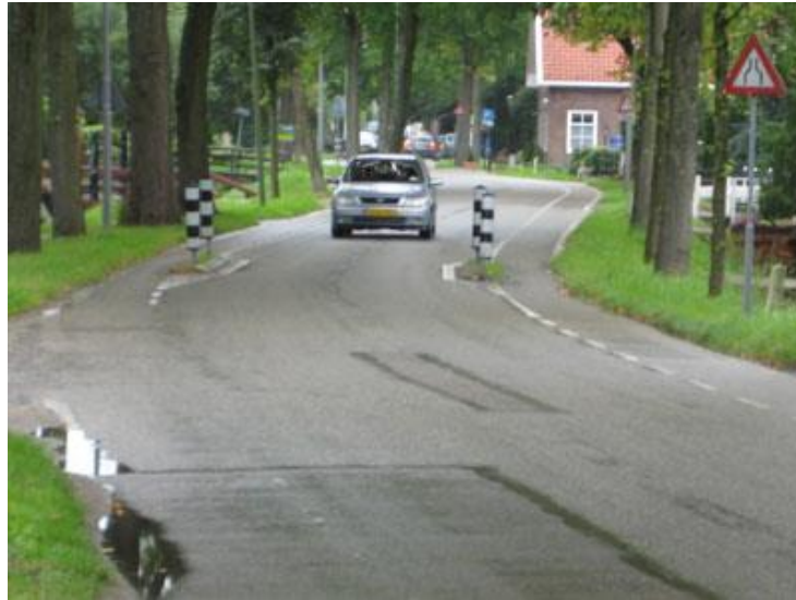
Figure 46: a simple road narrowing (source: http://www.nieuwemeer.info/nieuws/pdf/herinrichting_nwmeerdijk_dec_2007/voorbeeld- wegversmalling.jpg ).
