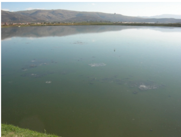
Afbeelding 2. Gasvorming in de primaire facultatieve lagunes, wat duidt op anaerobe omstandigheden
