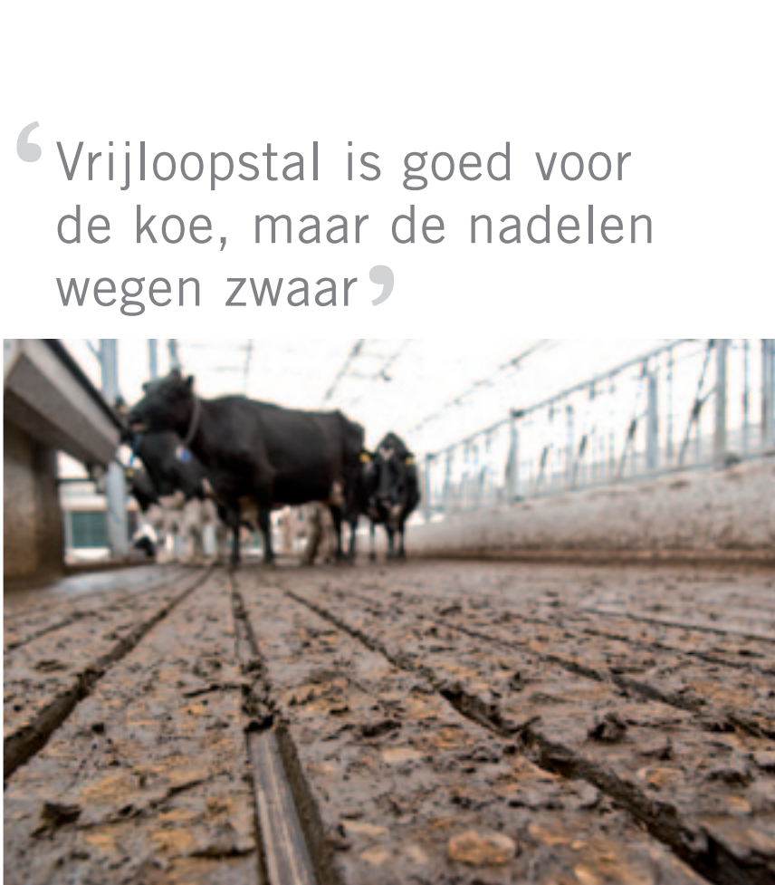
Met een emissiearme vloer achter het voerhek, wordt de ammoniakemissie uit een vrijloopstal lager. Of dat de stal emissiearm maakt, is nog de vraag.
