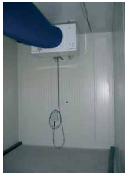
Een ULO cel is gasdicht om de samenstelling van de lucht te kunnen regelen
