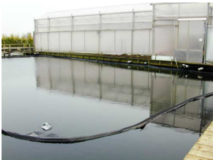
Figuur 3.7 Drijvend open reservoir (bron: PPO-Bomen)
