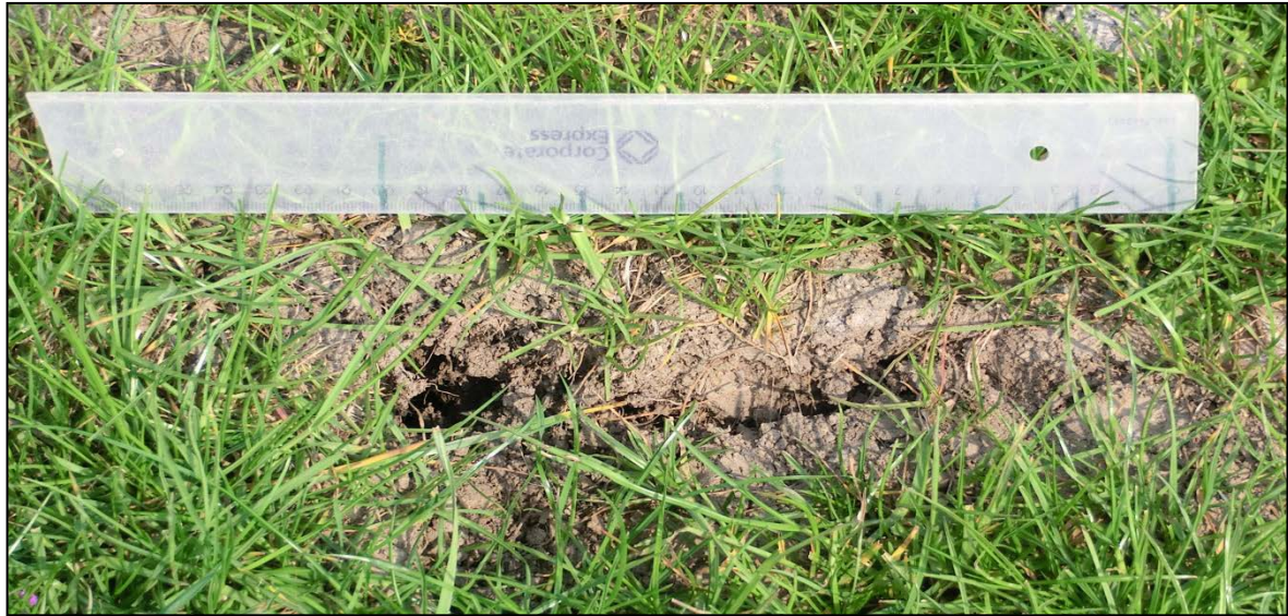
Foto 4 Lengtescheur van circa 25 cm lang.
