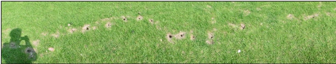
Foto 2 Spoor van gaten in de lengterichting van de dijk, ter hoogte van de oude scheur.
