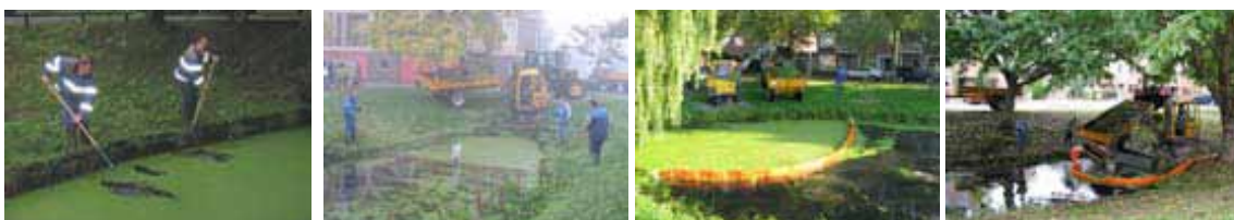
FIGUUR 6.1 HANDMATIG VERWIJDEREN VAN KROOS NA SAMENTREKKEN KROOS MET KROOSSCHERM
