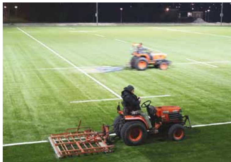
Zes uur 's avonds: de zandlaag wordt geëgaliseerd en afgewerkt. Om zeven uur 's avonds worden alle machines weer geladen.
