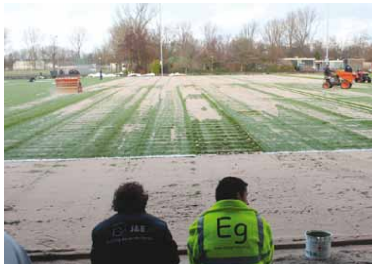
Twee uur 's middags: de laatste lijmwerkzaamheden; al het aanwezige materieel wordt ingezet om zand te strooien en in te vegen.
