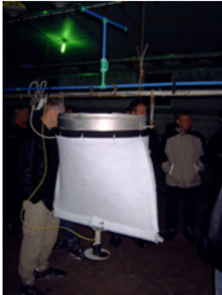
Figuur 4 Interne luchtreiniging door middel van filters en vernevelen zwavelzuur
