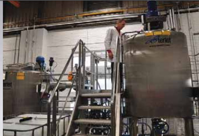
De ketel waarin de bietenpulp wordt afgebroken naar monomere suikers (begin van het proces).
