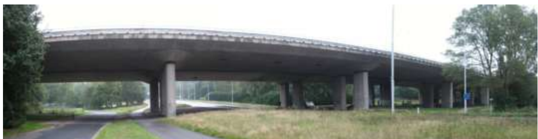
Figuur 12: Panoramafoto van het Beekdalviaduct, genomen vanaf Heelsum (westelijke zijde) (ten Doeschate et al., 2007)
