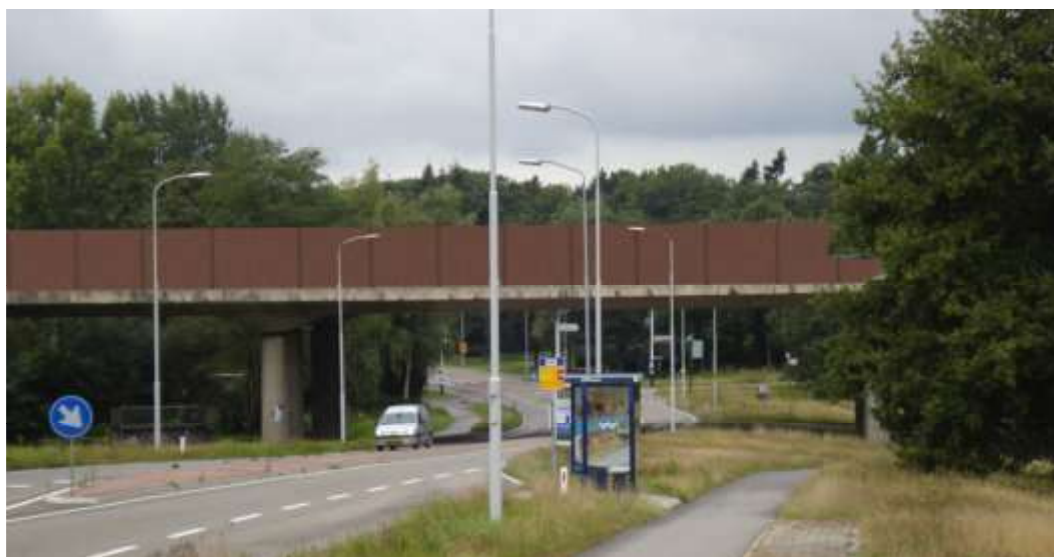
Figuur 17: Een fotomontage van het Beekdalviaduct met daarop als voorbeeld 4 meter hoge geluidsschermen met een verroeste ijzeren bekleding. Foto genomen vanaf de oostzijde van het viaduct en daarna bewerkt
