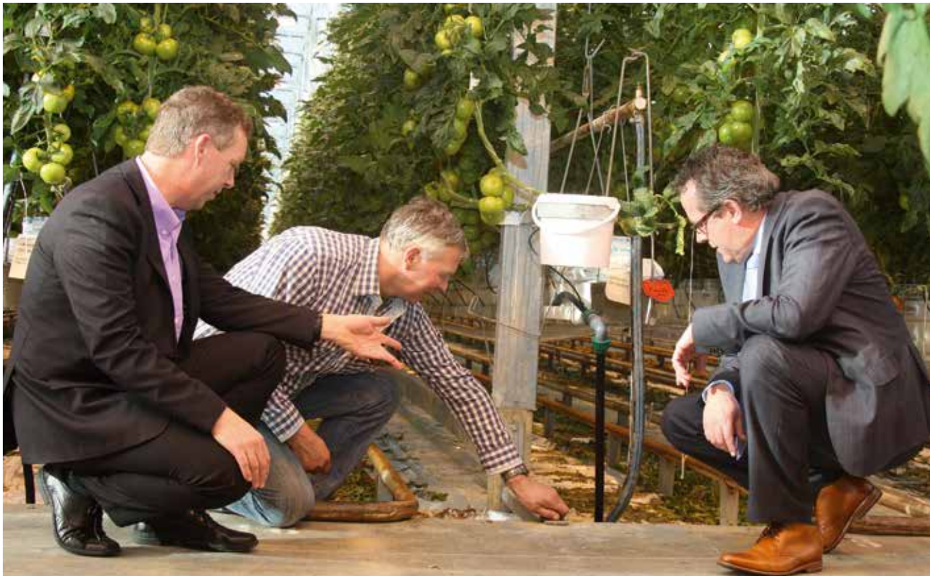
Teler Geert van Adrichem laat aan Tom Kester (links) en Hans Broch de extra schoren naar het betonpad zien. Door deze extra schoren voldoet de verhoogde kas aan dezelfde maatstaven als een nieuwe kas van dezelfde hoogte.
