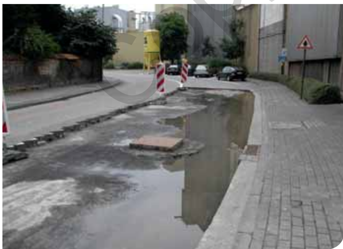
Straatstenen met waterdoorlatende eigenschappen op zich voldoen niet! Belangrijk is dat de volledige structuur waterdoorlatend is.
