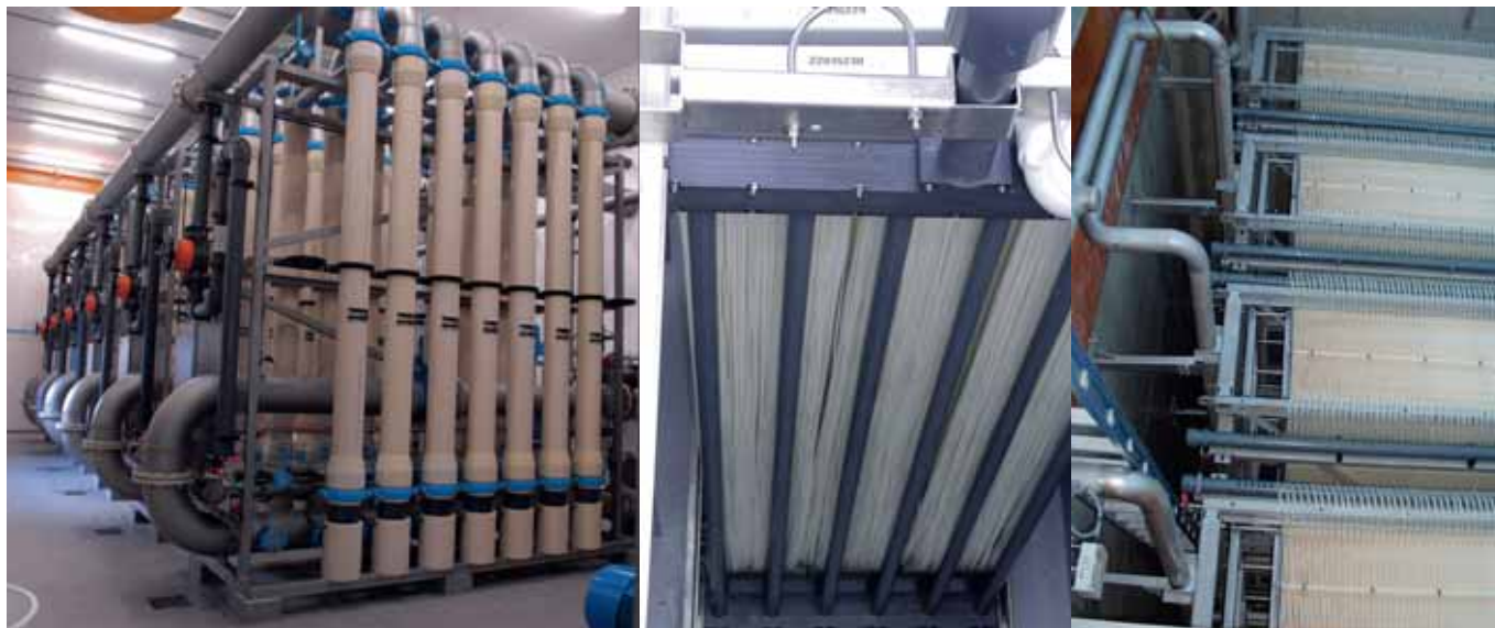
De membraansystemen die zijn geïnstalleerd bij de drie onderzochte MBR systemen. Links: Ootmarsum, midden: Varsseveld en rechts: Heenvliet.
