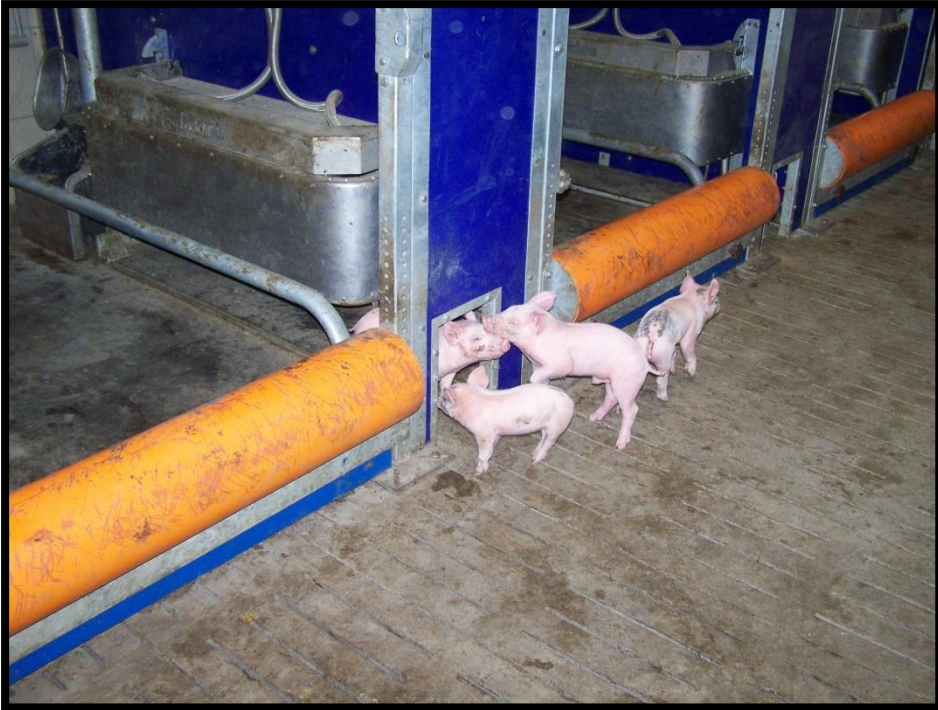
Figuur 9. Werphokken met een biggenluikje in de conceptstal 'Pig Production 2030' van Big Dutchman.
