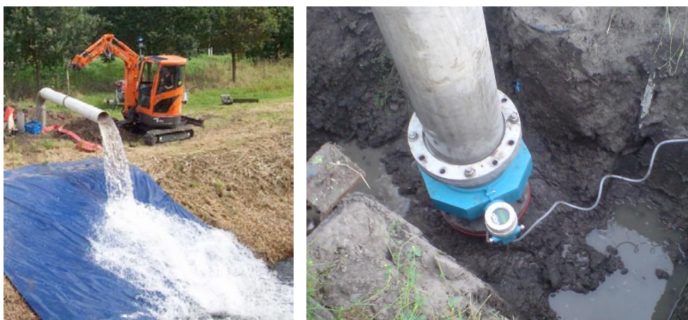
Afbeelding 1. Spui-opstelling voor het spuien (links); volumestroommeter (rechts)
