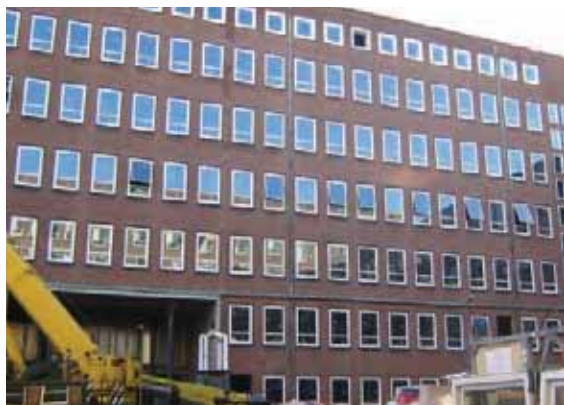
Tijdens de renovatie van het LNV gebouw zijn kozijnen van inheemse lariks geplaatst.
