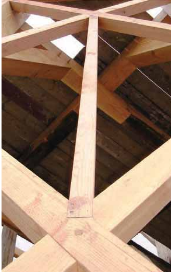
De molen Massier in Nieuw Leusen is gerestaueerd met forse balken van douglas
