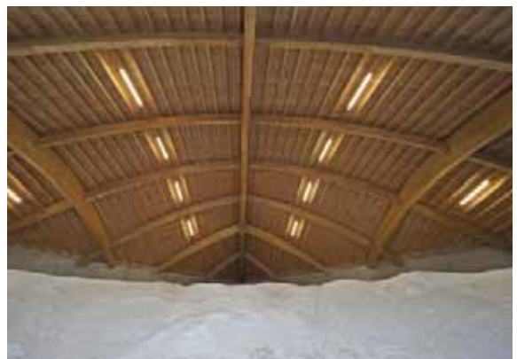
Zoutloods in Breda met gelamineerde spanten van inheemse lariks en verduurzamde Nederlandse douglas voor het dakbeschoot
