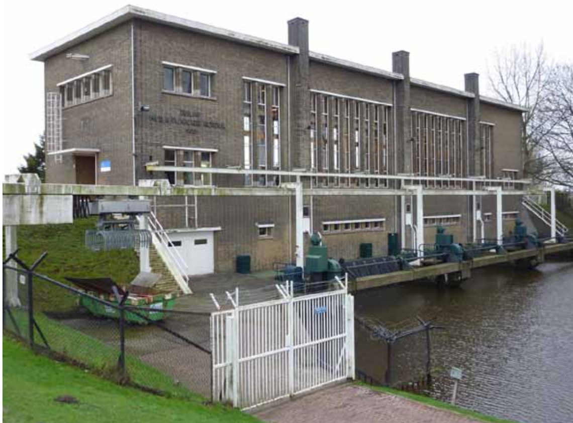
De huidige toevoer voor de watervoorziening van het Groene Hart. Dit gemaal (Pijnacker Hordijk) bij Gouda werd in 1936 in gebruik genomen.
