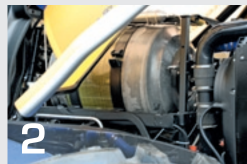
▲ In deze 100 liter-tank slaat de trekker zijn waterstof op.
