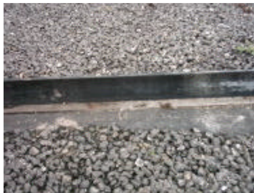
Figuur 3: Opstaande rand op een eb- en vloedveld Bron: A. Hengeveld
