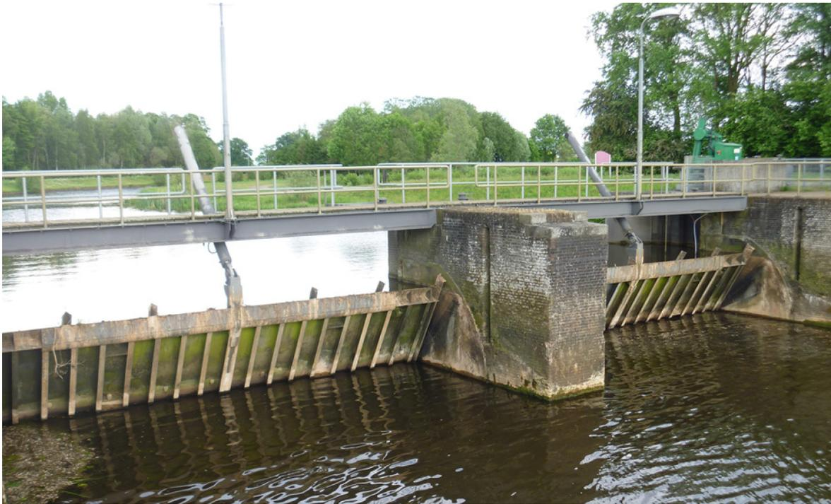
**Abbildung 9** Stauwehr bei De Haandrik. Mit der telemetrischen Steuerung der Wehre werden die natürlichen Wasserstandschwankungen gedämpft. Der Wasserstand muss auf die Renaturierungsmaßnahmen oberhalb und unterhalb des Stauwehrs abgestimmt werden.
