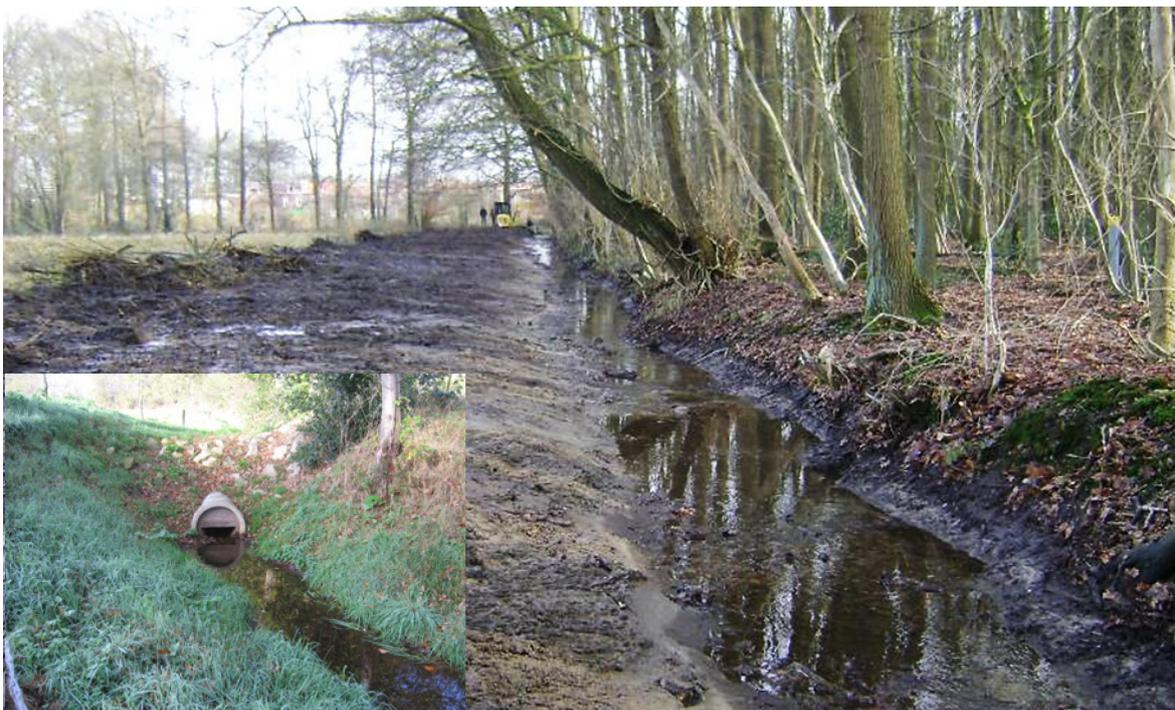
**Abbildung 11** Stauwehre oder Düker mit einer beschränkten Abfuhrkapazität, sogenannte knijpduiker, eingebaut in kleine Entwässerungsgräben, wodurch der Wasserabfluss verlangsamt wird.
