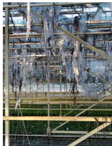
Kortsluiting in lampen, ontstekers en schakelkasten is meestal de oorzaak van brand.
