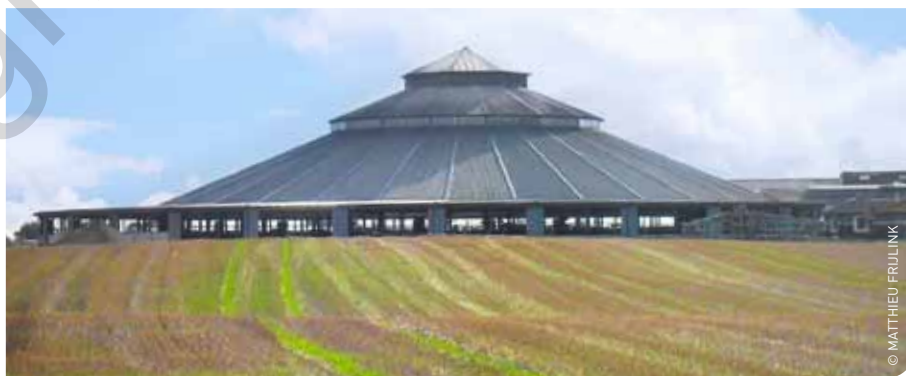
De ronde stal van de familie Kuhr biedt plaats aan 550 melkkoeien rond een centrale draaimelkstal. De 21 m hoge nok zorgt voor een optimaal schoorsteeneffect en aangenaam klimaat.
