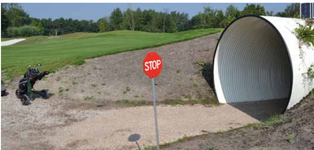
Dankzij een tunnel zijn de problemen van het greenkeeper- en golfersverkeer op twee kruisende fairways verleden tijd.
