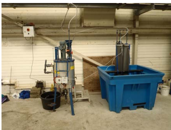
Figuur 2: Opstelling pilotinstallatie op rwzi Bath
