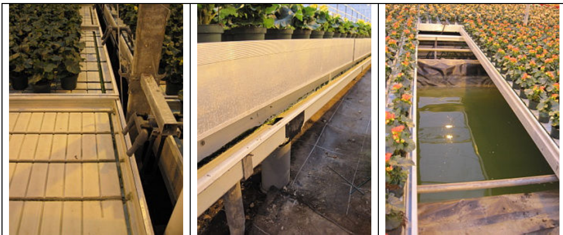
Foto 5: Eb en vloed watergeefstelsel. Links inlaat voedingswater; Midden drainwateropvanggoot; Rechts opvangbassin drainwater onder de containers.
