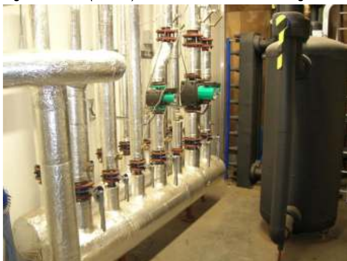
Figuur 10: Het (zwarte) buffervat van de koude kring
