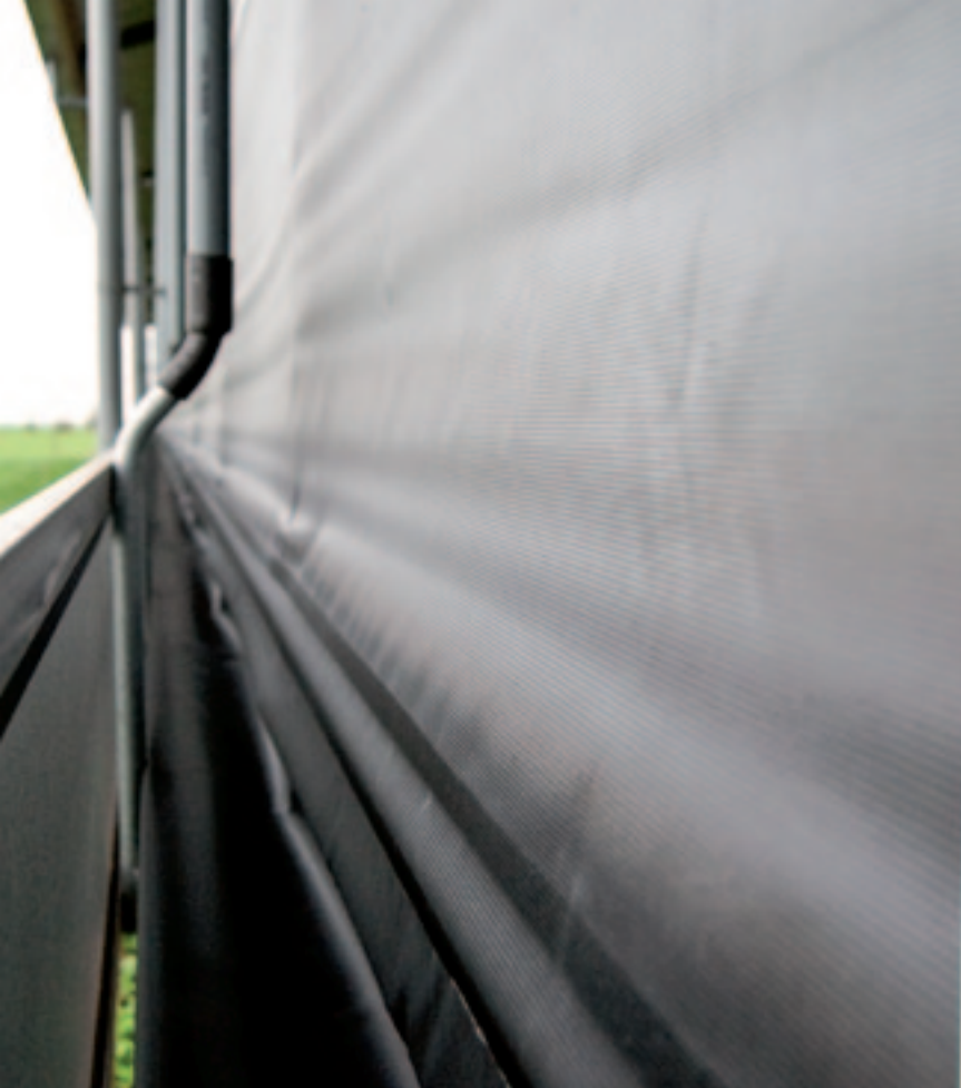
Tegenwoordig zijn stal gordijnen beschikbaar die zich opvouwen in plaats van oprollen. Zoomen in het gordijn zorgen dat het zichzelf opvouwt.
