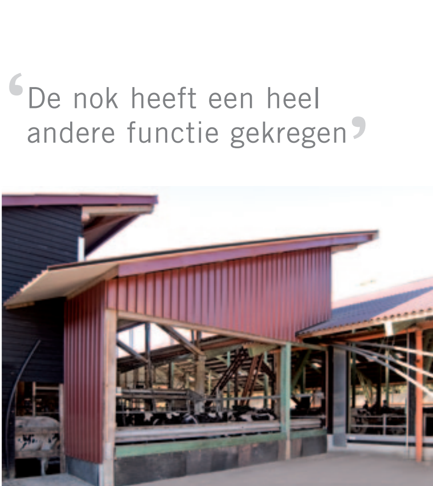
Een zaagtanddak is een manier om veel luchtinlaatoppervlakte te bereiken zonder een sessie te doen aan de dakhelling.
