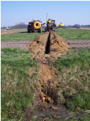
Figuur 1: Een nieuwe drain wordt aangelegd
