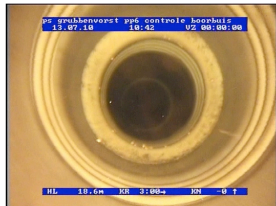
Afbeelding 4. Verlijmde, niet lekkende kordeldraadverbinding
