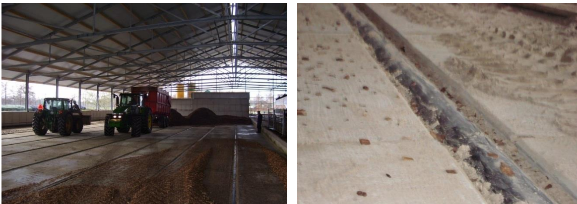
Figuur 1 Het vullen van de composteringsbodem met snippers (links) en een detail van het beluchtingssysteem (rechts).
