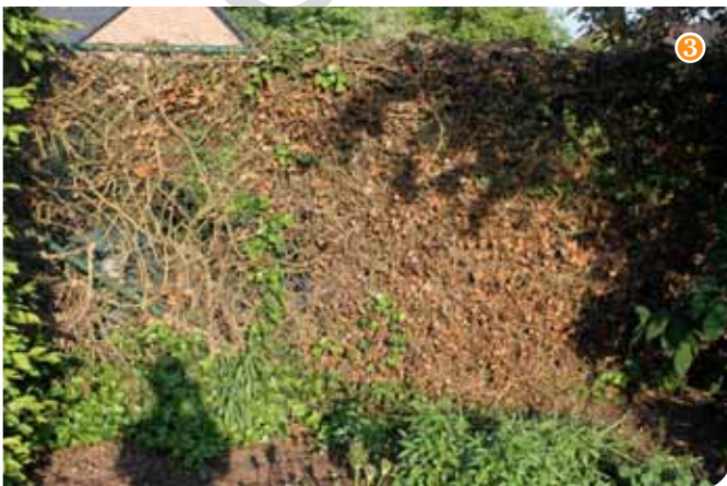
▲ Algemeen schadebeeld (foto L. Bernaerts)
