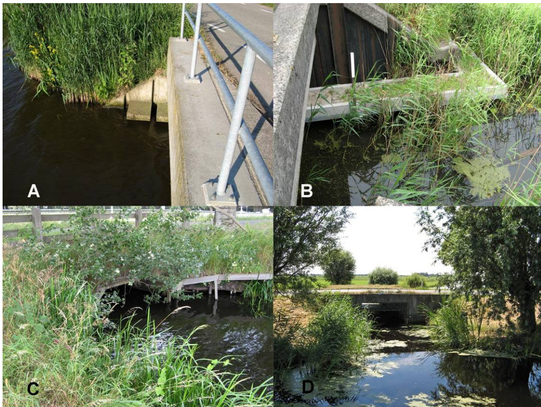
Figuur 2.1. Looprichels onder duikers bij respectievelijk Negen Viertel (A; niet goed aansluitend op de oever), A12 (B) en de A1 (C; overigens te hoog voor otters). In de Krimpenerwaard werd een muskusrat-vangconstructie aangetroffen die de onderdoorgang bij de brug volledig blokkeerde (D). Foto's Freek Niewold.
