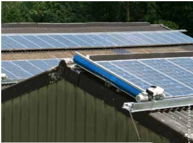
Bij Rudy Bayens worden 2 types van hetzelfde reinigingssysteem getest. Foto boven: rechts het systeem met één motor. Foto onder: de tweemotorige versie.
