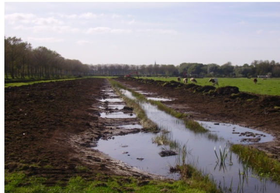
Aanleg van natuurvriendelijke oevers in de polder van Biesland, 2009. (Foto Marietta van der Duyn Schouten).
