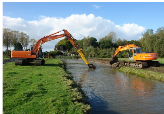
Aanleg van natuurvriendelijke oevers in de polder van Biesland, 2009. (Foto Fabrice Ottburg).
