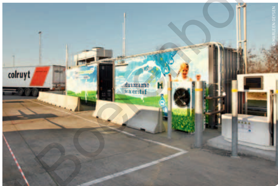
Het waterstoftankstation van Colruyt wordt gevoed met overtollige energie van de zonnepanelen en de windmolens.
