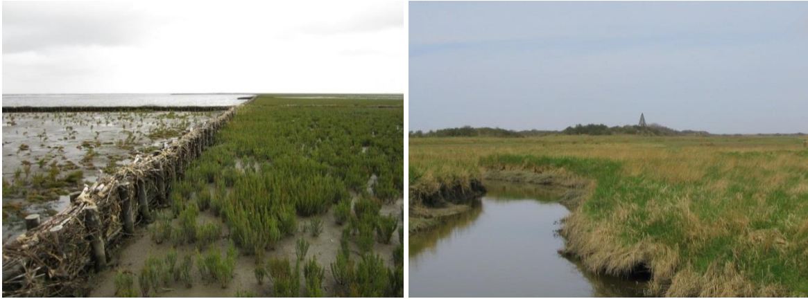
Figuur 11. Pionierzone in de vastelandskwelders, ontstaan in de luwte van rijshoutdammen (links). Hoge oude kwelder op Schiermonnikoog (rechts). (Foto's: Alma de Groot).
