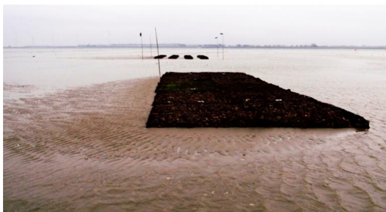
Figuur B 1. Schanskorven met oesters, die als kern voor een oesterrif moeten fungeren. (Foto: Brenda Wallès).
