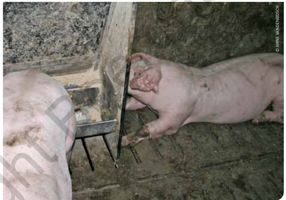
De hokken kregen een vloer op maat. VDV Beton bracht een bijkomende gleuf aan tussen de panelen en de rooster zodat het reinigen vlotter verloopt.
