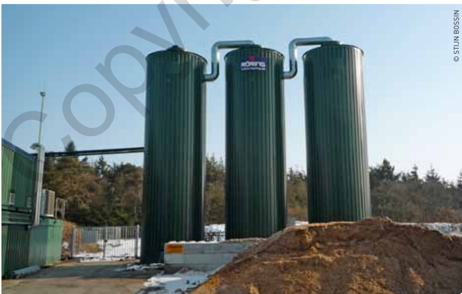
De UDR-vergister splitst het vergistingsproces in 3 delen.
