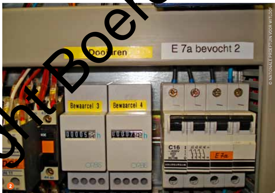
1 Een thermostatisch (links) versus elektronisch (rechts) expansieventiel. 2 Meten is weten. Met enkele eenvoudige en relatief goedkope urentellers kan de werking van een koelinstallatie goed opgevolgd worden.
