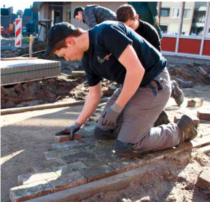
Groenleerlingen van CC Schaersvoorde maken onder leiding van een stratenmaker straatwerk bij een verzorgingshuis
