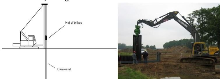
Figuur 19 Aanbrengen pipingscherm (rechts) (Concept Waterkerende verticale afdichtingen, 2013), Aanbrengen pipingscherm in praktijk (links) (Damwanden, 2013)
