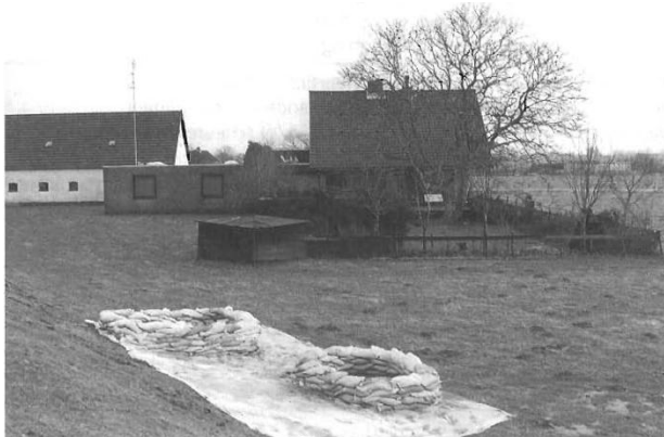
Figuur 13 Opgekiste zandmeevoerende wellen (Niemeijer, 1996)
