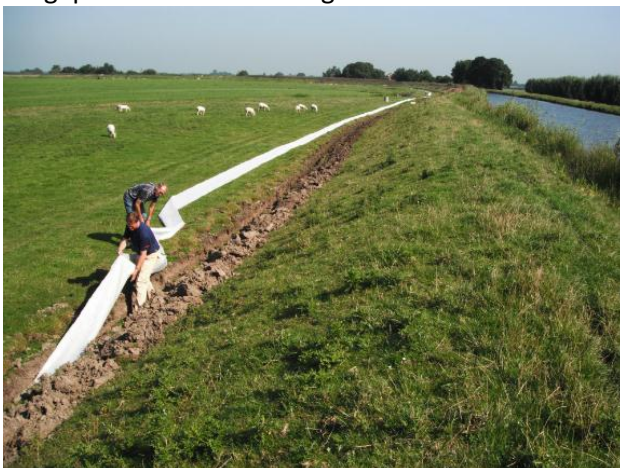
Figuur 15 Plaatsen verticaal zanddicht geotextiel(TenCate GeoDetect® voor dijkmonitoring, 2012)
