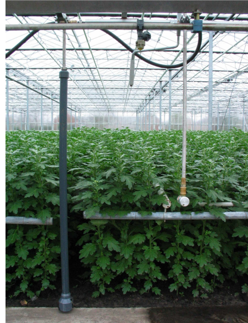
Rechts een korte zakpijp en links een lange zakpijp, beide gemonteerd aan een standaard spuitboom
