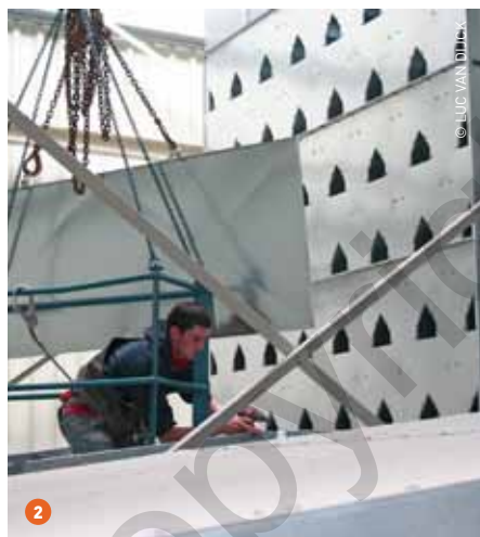
1 De droogtoeren is het hart van het complex (zie foto p. 46). In de loods kan 15.000 ton. 2 Een tweede droger is in opbouw. De doorsteken in dakkapelvorm waardoor de hete lucht stroomt, zijn goed te zien. 3 Het droogproces verloopt volledig computergestuurd.
