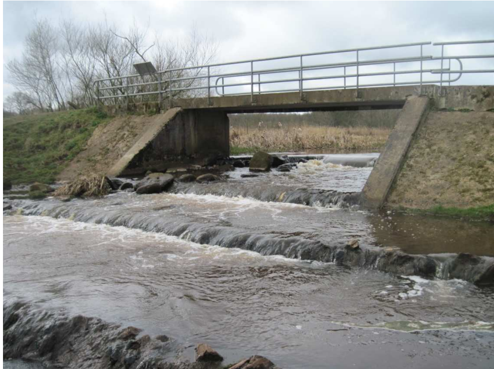
figuur 2.2 De vispassage in het Peizerdiep met op de achtergrond de smalle doorgang.
