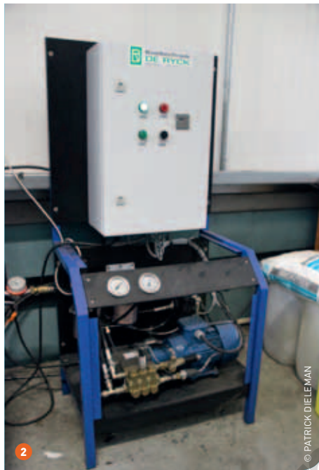
1 Hier zien we een deel van de koelinstallatie. Rechtsvooraan bevindt zich het buffervat voor de koelvloeistof. Links daarvan de 9 pompen die elk instaan voor de koeling in een van de 9 bewaarcellen. Vooraan zie je de koppelingen voor een noodkoelgroep. 2 Behalve deze scrubber die het CO 2 -gehalte onder controle houdt, is er bij de nieuwe installatie ook een stikstofgenerator voorzien.
