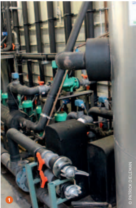
1 Hier zien we een deel van de koelinstallatie. Rechtsvooraan bevindt zich het buffervat voor de koelvloeistof. Links daarvan de 9 pompen die elk instaan voor de koeling in een van de 9 bewaarcellen. Vooraan zie je de koppelingen voor een noodkoelgroep. 2 Behalve deze scrubber die het CO 2 -gehalte onder controle houdt, is er bij de nieuwe installatie ook een stikstofgenerator voorzien.
