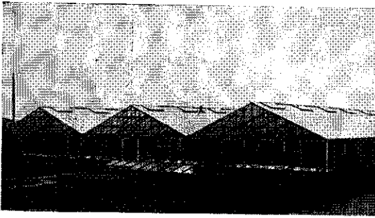
Vaste Veense kas. Kapspanning 9,40 m.
