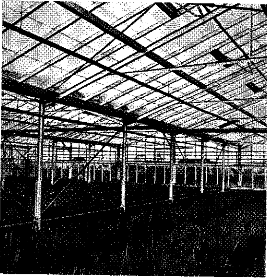
Verrolbare Veense kas in de Veenstreek. Teelt van fresia's die in de open grond zijn uitgezaaid, waarna in september de kas op het gewas is gebracht
