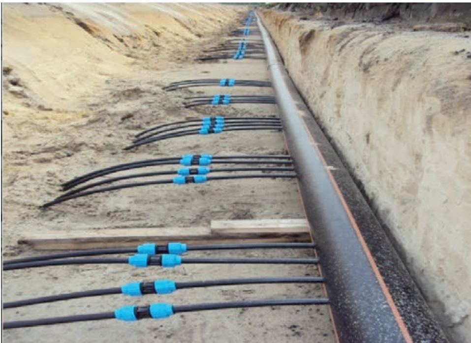
Figuur 2. Slangenbuffer en distributieleiding (Foto Cogas Zuid).
