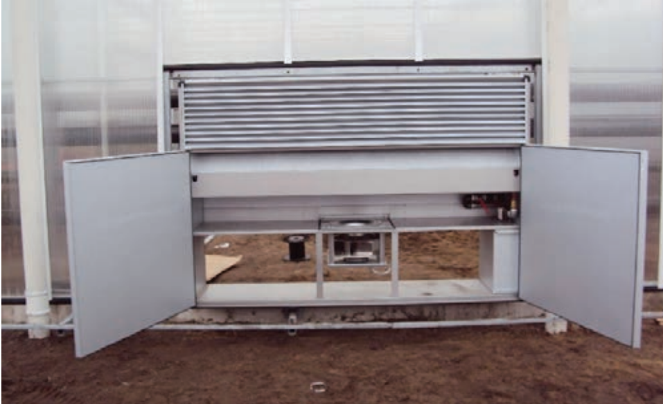
Figuur 1. Installatie van de luchtbehandelingskast in de gevel (Foto Cogas Zuid).
