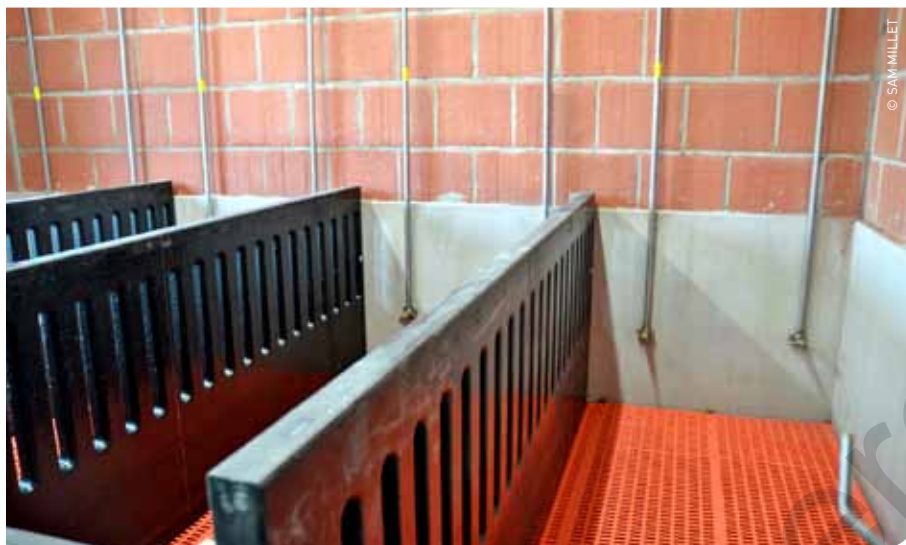
Alle hokken zijn uitgerust met een dubbel drinkwatercircuit.
